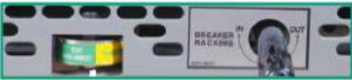
断路器位置指示器 及机械闭锁操作投退手柄
